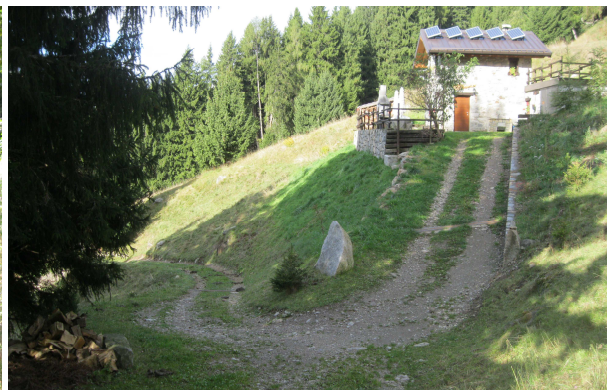
Strada accanto alla quale verrà posato il pozzetto AIB
