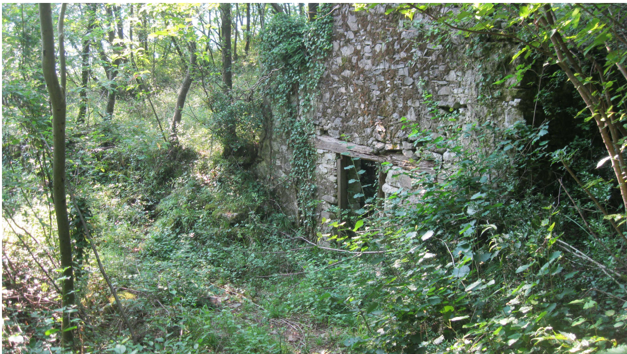
Mulattiera su cui verrà interrato l'acquedotto AIB
