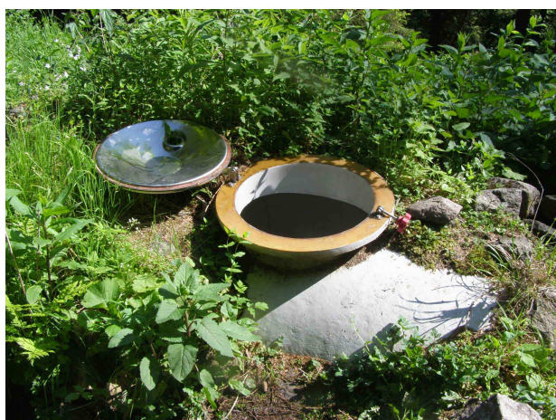
Area in cui verrà posata la nuova vasca
