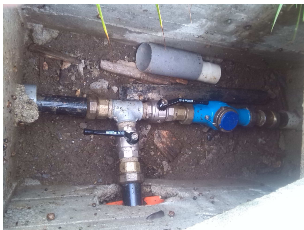
Pozzetto dell'acquedotto su cui realizzare il BY-pass
