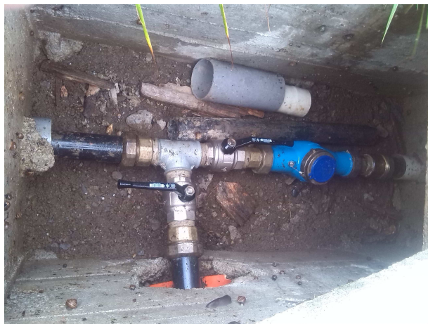
Pozzetto dell'acquedotto su cui realizzare il BY-pass
