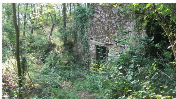
Tratto di mulattiera in cui verrà interrato l'acquedotto AIB
