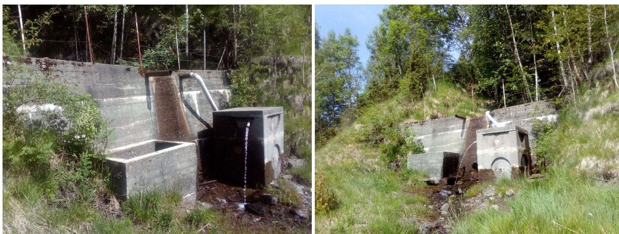
Vasca di accumulo
