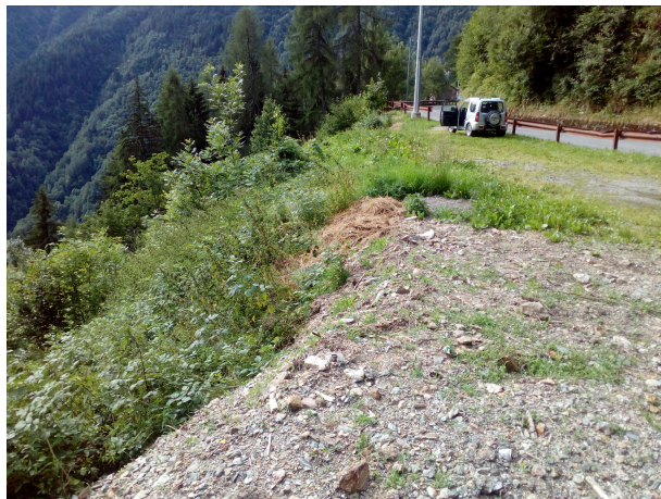
Area in cui verrà realizzata la palificata doppia
