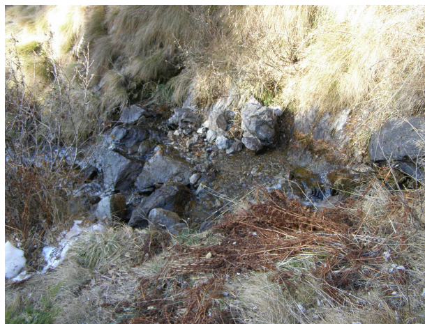
Tratto in cui verrà interrato il pozzetto di captazione AIB
