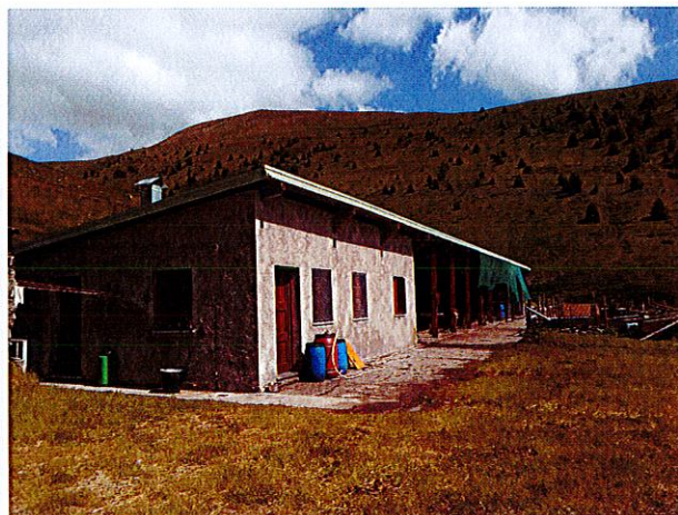
Localizzazione Pozzetto n. 3 (Malga Mola Alta)
