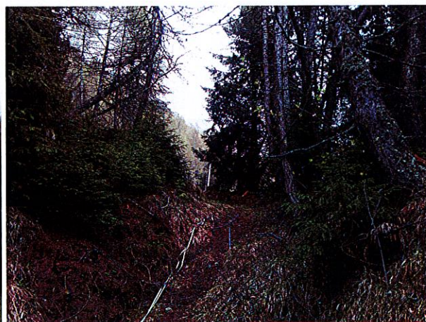
Interramento acquedotto AIB
