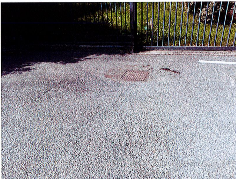
Tratto in cui verrà interrato l'acquedotto
