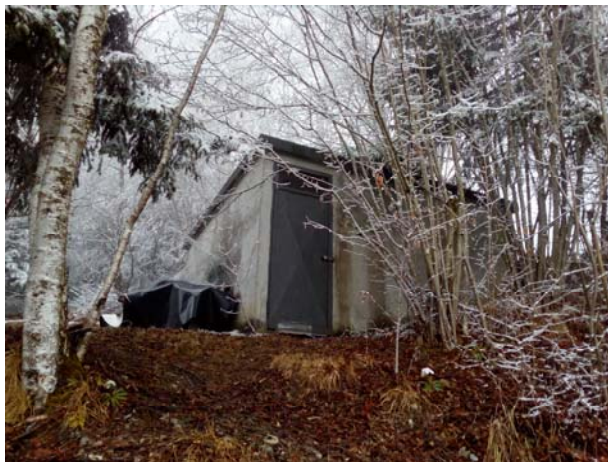
Vasca dell'acquedotto da cui si effettuerà la derivazione dell'acqua
