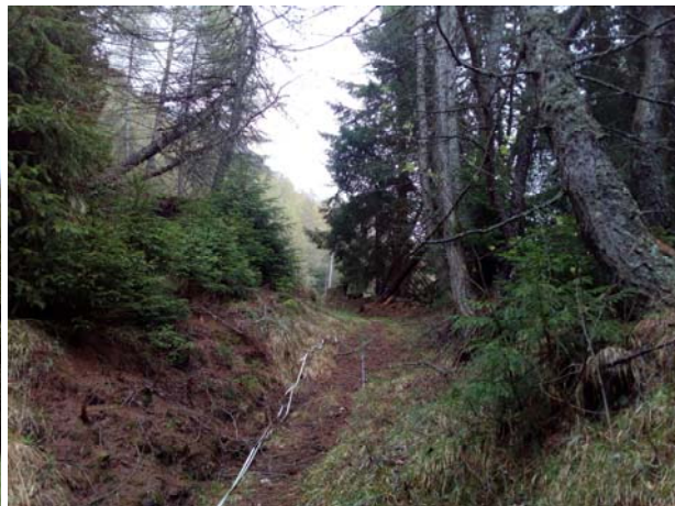
Interramento acquedotto AIB
