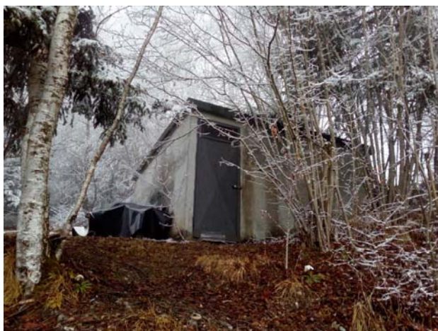
Vasca dell'acquedotto da cui si effettuerà la derivazione dell'acqua
