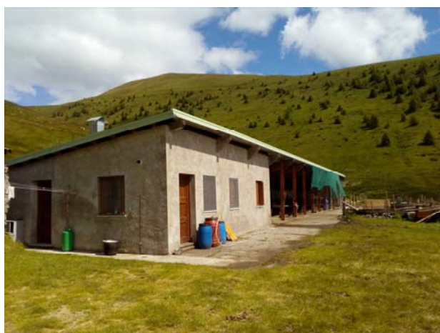
Localizzazione Pozzetto n. 3 (Malga Mola Alta)
