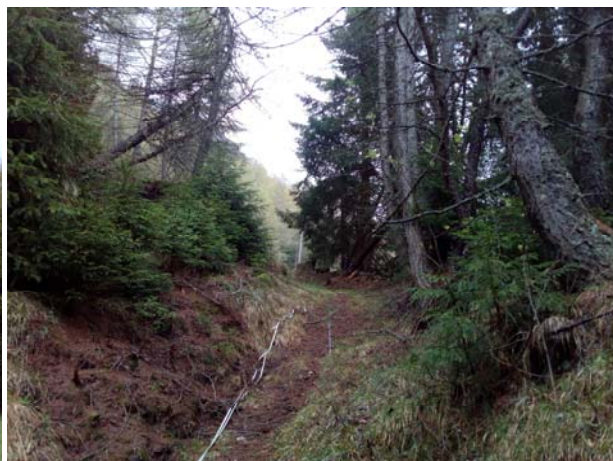
Interramento acquedotto AIB
