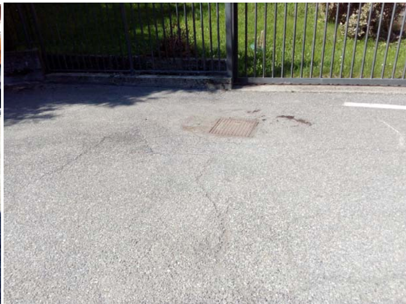
Tratto in cui verrà interrato l'acquedotto
