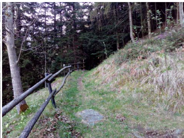
Tratto terminale dell'acquedotto AIB
