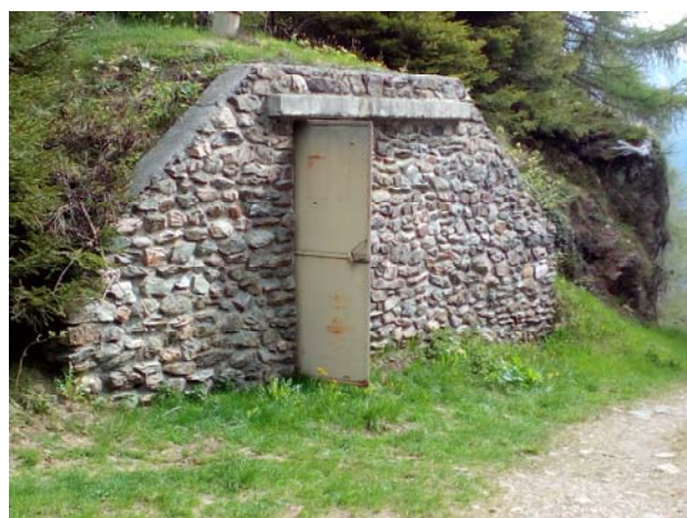
Vasca presso la quale verrà posato l'idrante AIB
