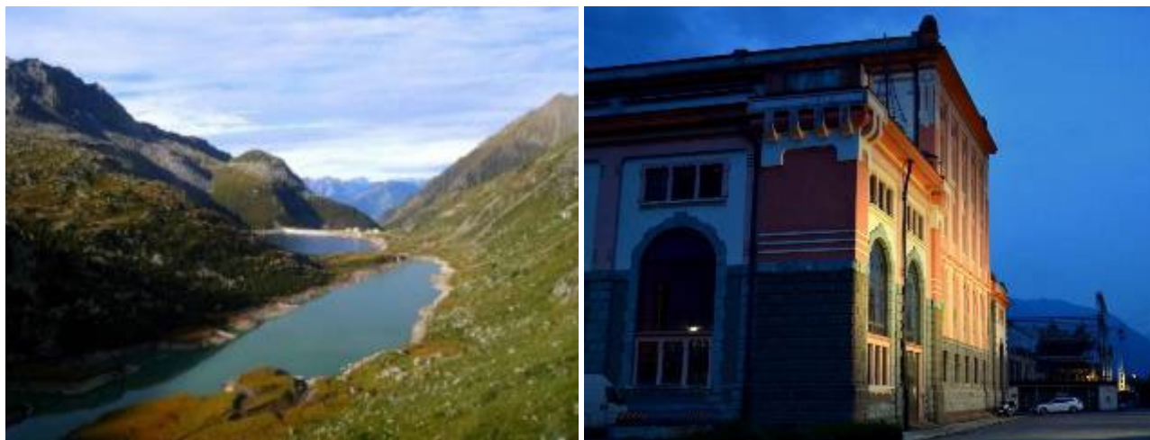
FIGURA 6. VAL SALARNO A SINISTRA, CENTRALE DI CEDEGOLO A DESTRA.
