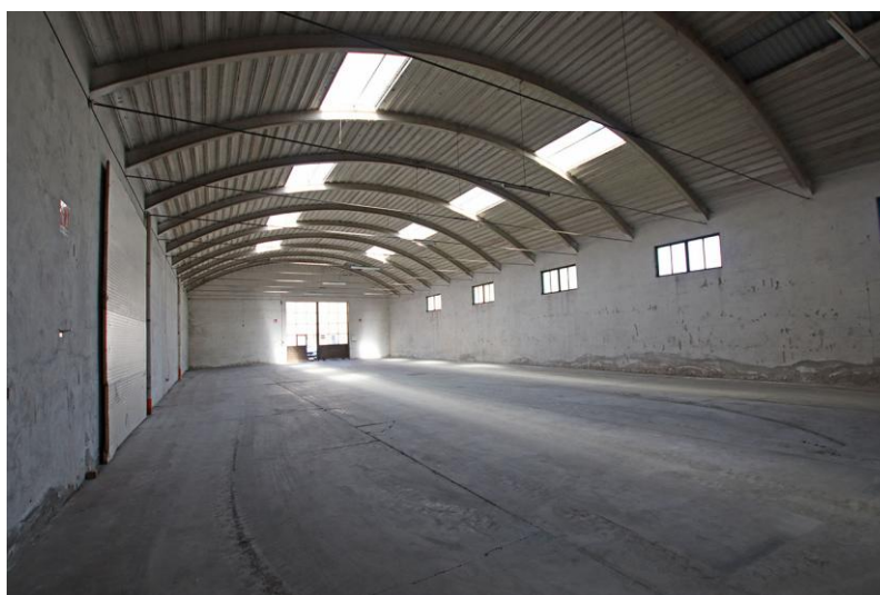
INTERNO CAPANNONE A
